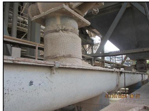
ภาพที่ 2.1 ระบบสายพานแบบปิดสำหรับลำเลียงฝุ่นจาก SP Boiler และ Precipitation Chamber
