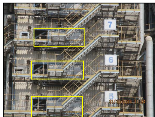
ภาพที่ 2.3 Casing หุ้มชุด Hammering Equipment ในหม้อไอน้ำ
